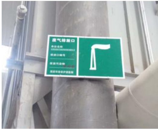
去皮切割机除尘器排气筒 P13
