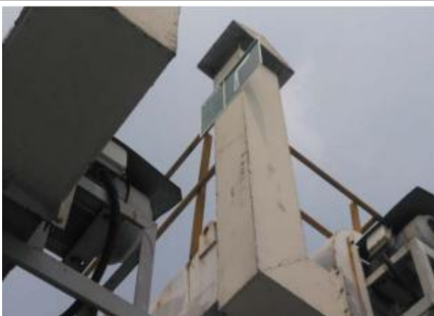
固化粉料仓除尘器排气筒 P 5
