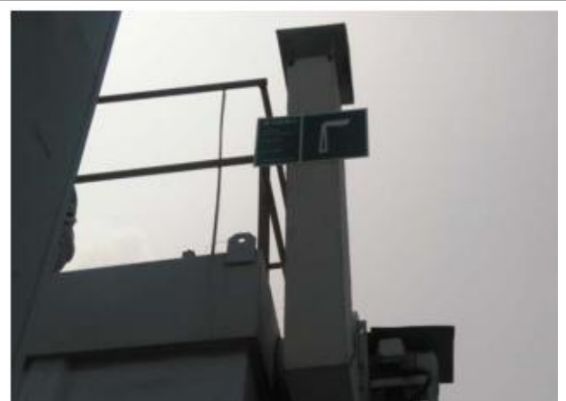
无机纤维料仓除尘器排气筒 P 6
