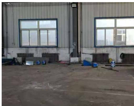
图 1-1 本项目厂房现状图
