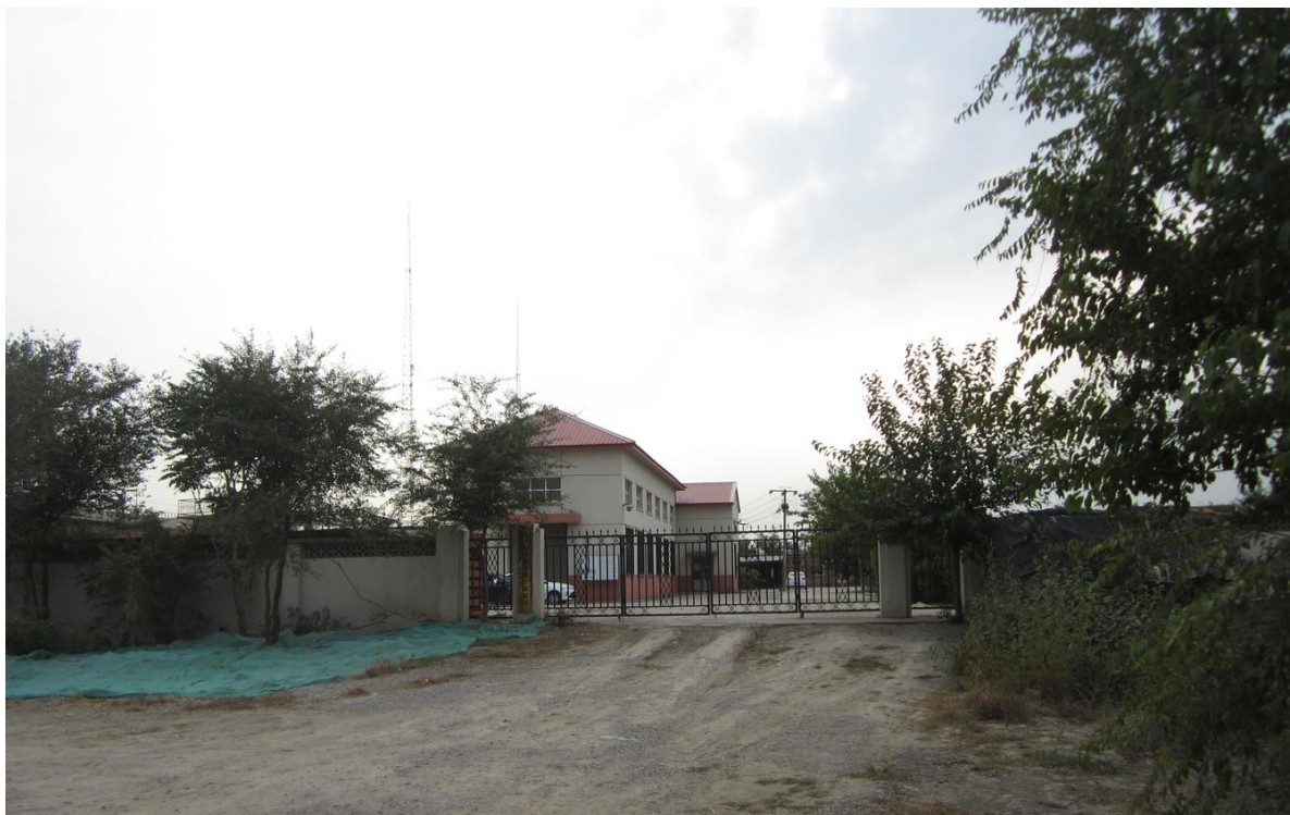
图 10 原有双洋渠泵站现状照片
