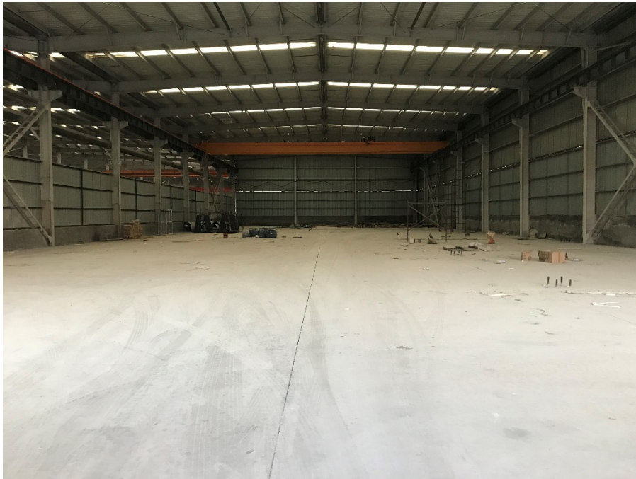
图 1-5 本项目厂房现状图
