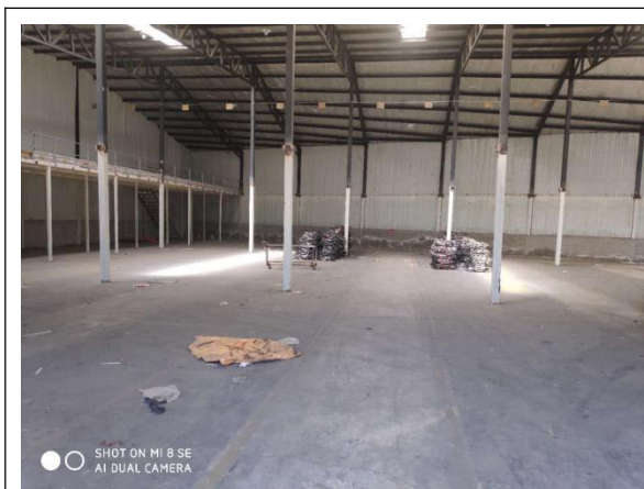
1#生产车间现状照片
