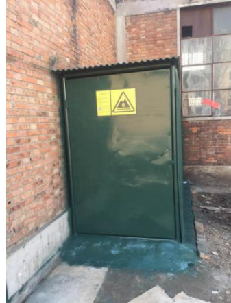
危废暂存间规范化
