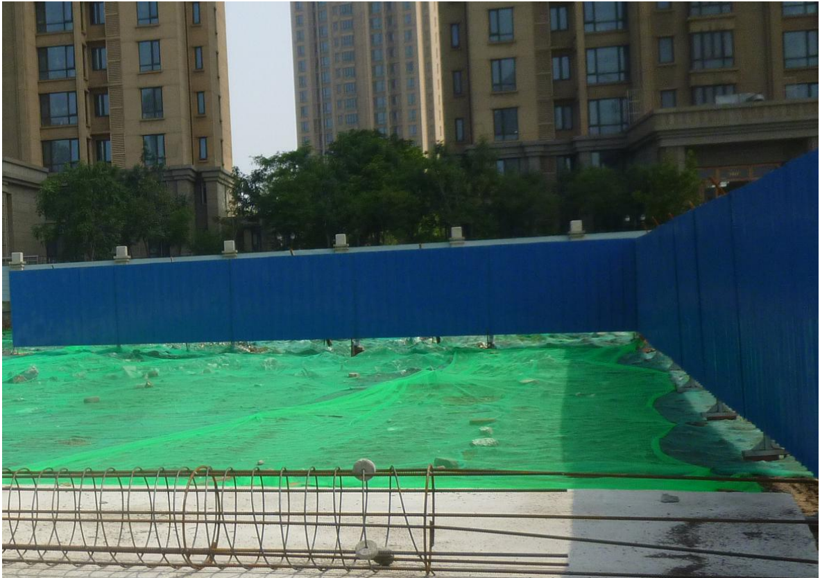
图 3-2 施工围挡照片
