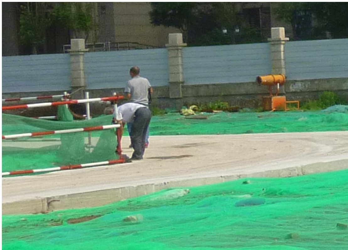
图 3-1 施工苫盖及雾炮抑尘照片
