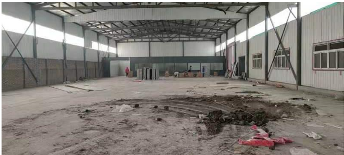
图 2-8 本项目厂房现状图
