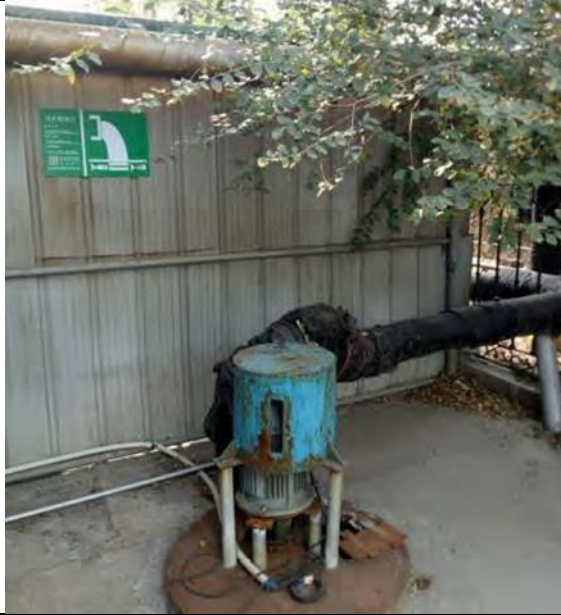
废水排放口标志牌
