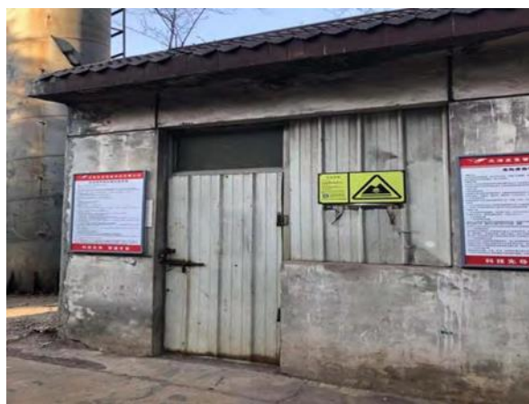
危险废物暂存场所
