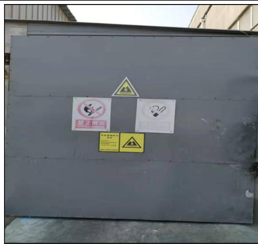
危废暂存间外部照片
