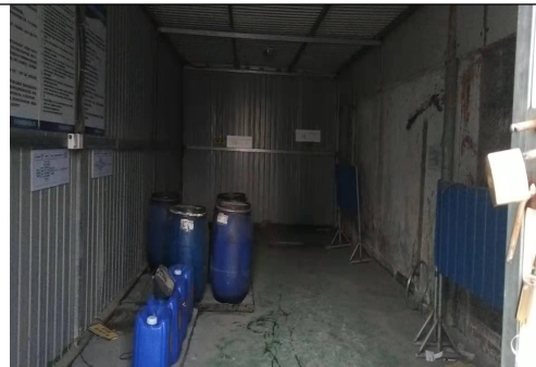
危废暂存间内部情况
