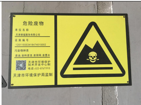
危废暂存间规范化
