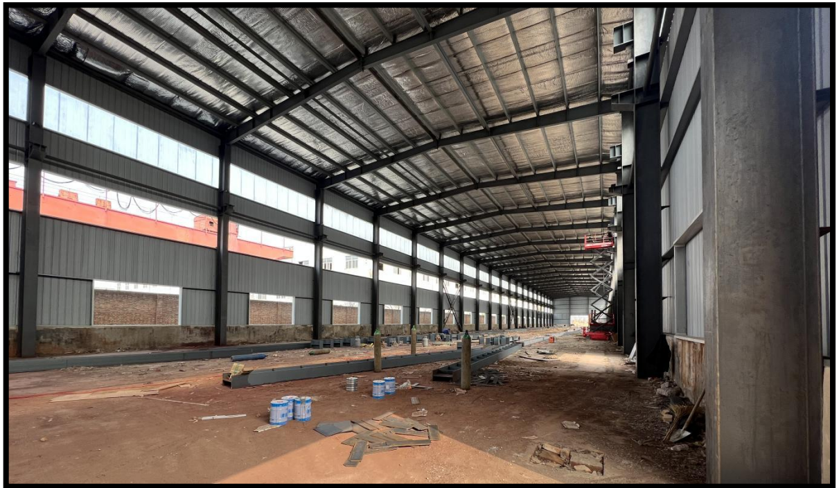
图 2.1-2 本项目选址处车间现状实拍图
