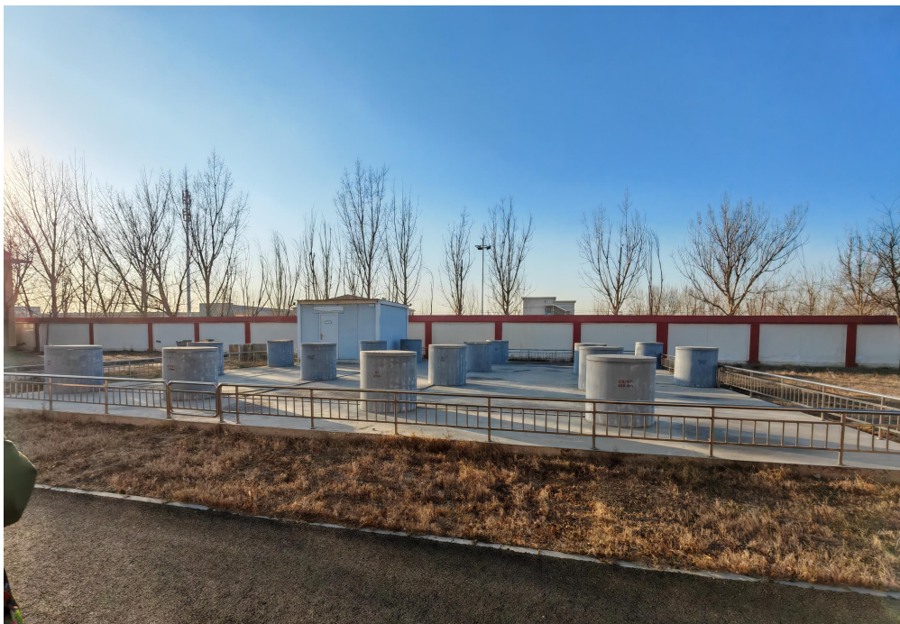
图4-4本项目建成后现场图
