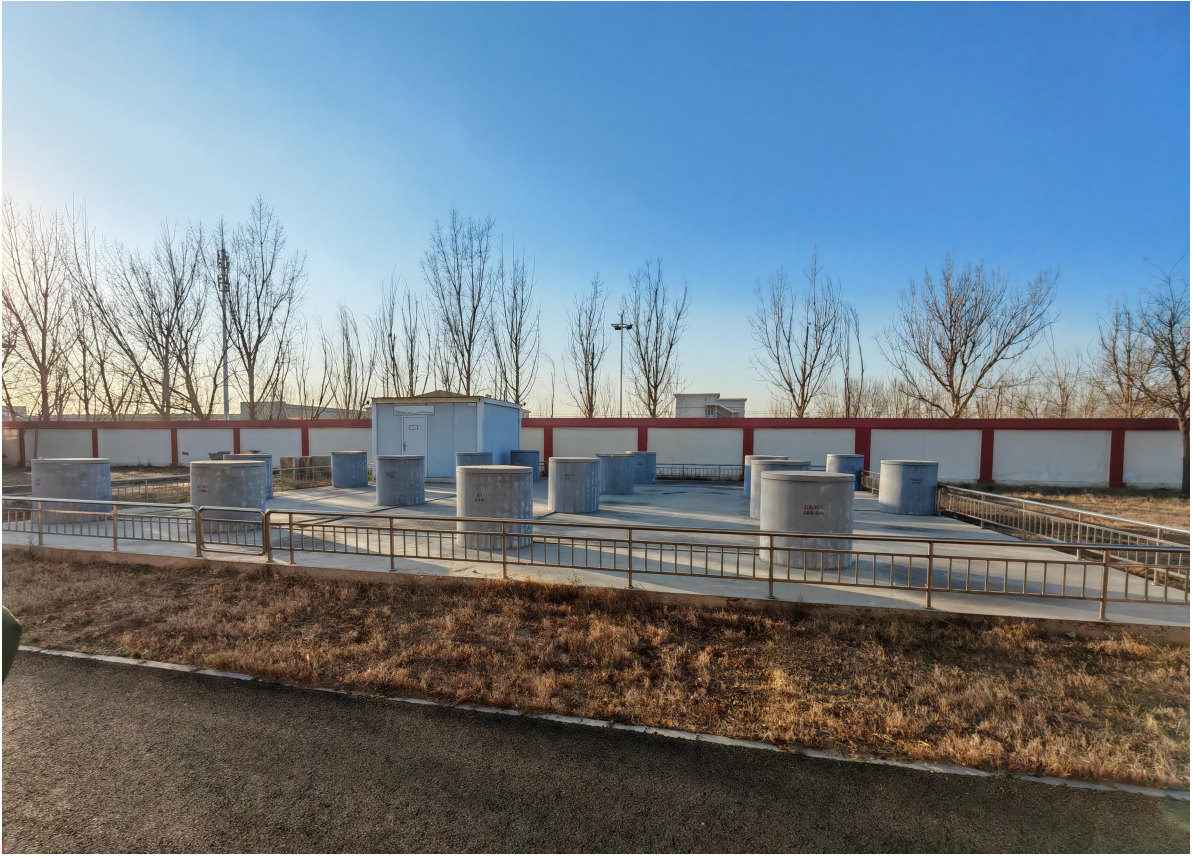
钻探标孔现场图
