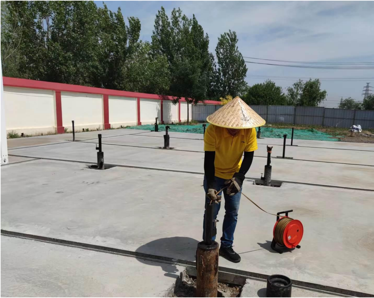
施工期现场环保措施落实情况图
