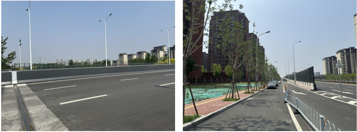
图4-18 本项目照明工程现状图
