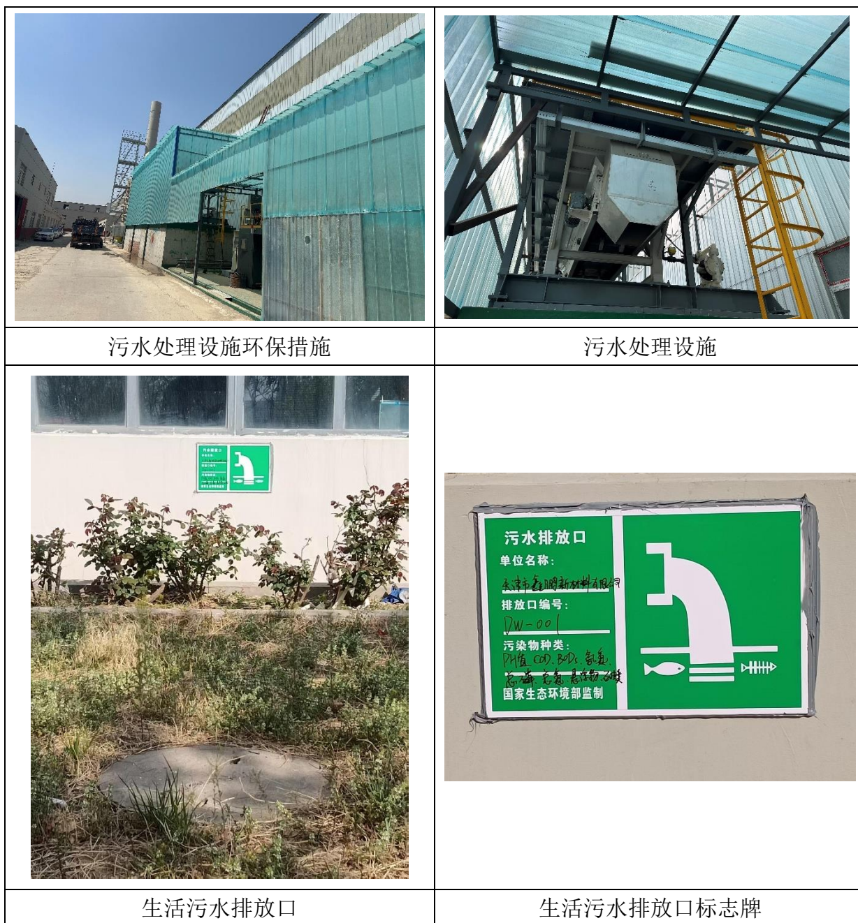
图 4-1 废水治理设施排放口规范化照片
